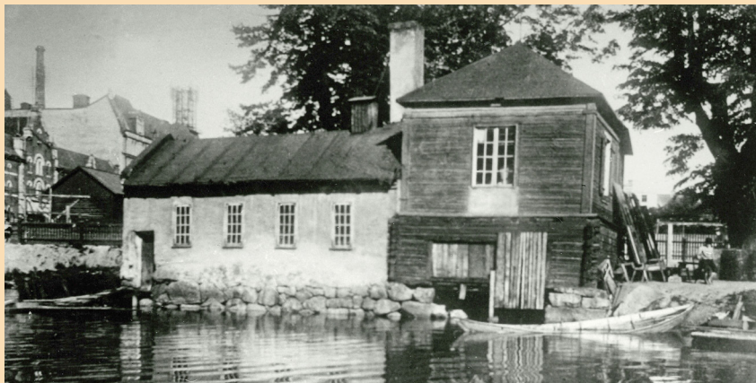
Lusthuset vid Lindhska boktryckerigården fanns kvar till början av 1900-talet men hade förlorat sin ursprungliga funktion. Här är huset ihopbyggt med ett senare uppfört bryggghus. Foto: Sällskapet Gamla Örebro's fotosamling, ArkivCentrum Örebro län.
